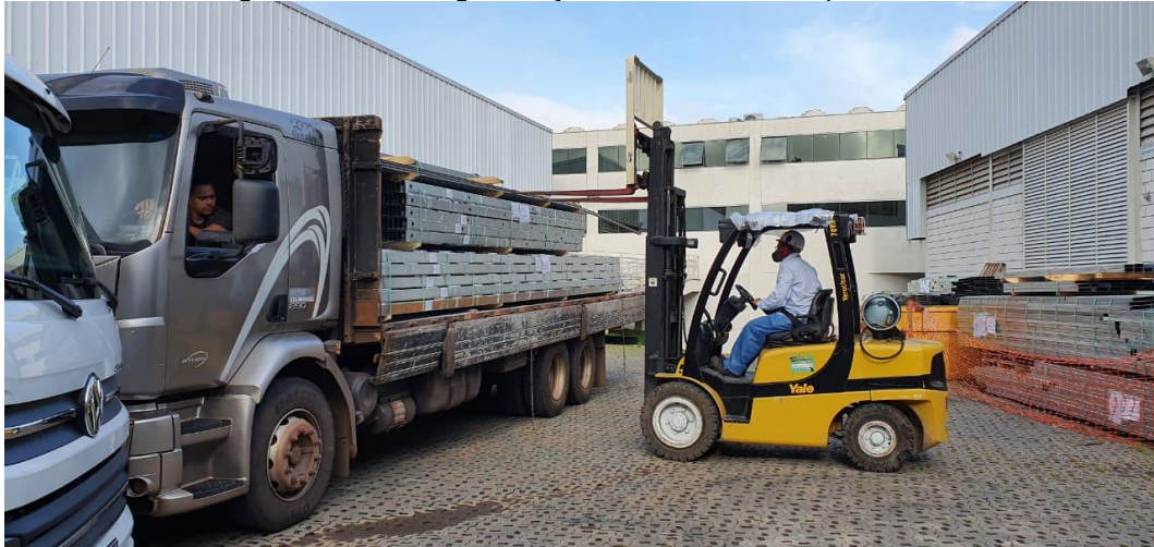
Figura 19 - Descarga do aço com auxílio de empilhadeira
