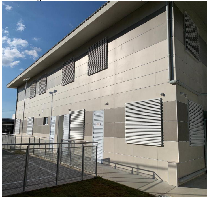
Figura 11 - Fachada aerada em porcelanato
