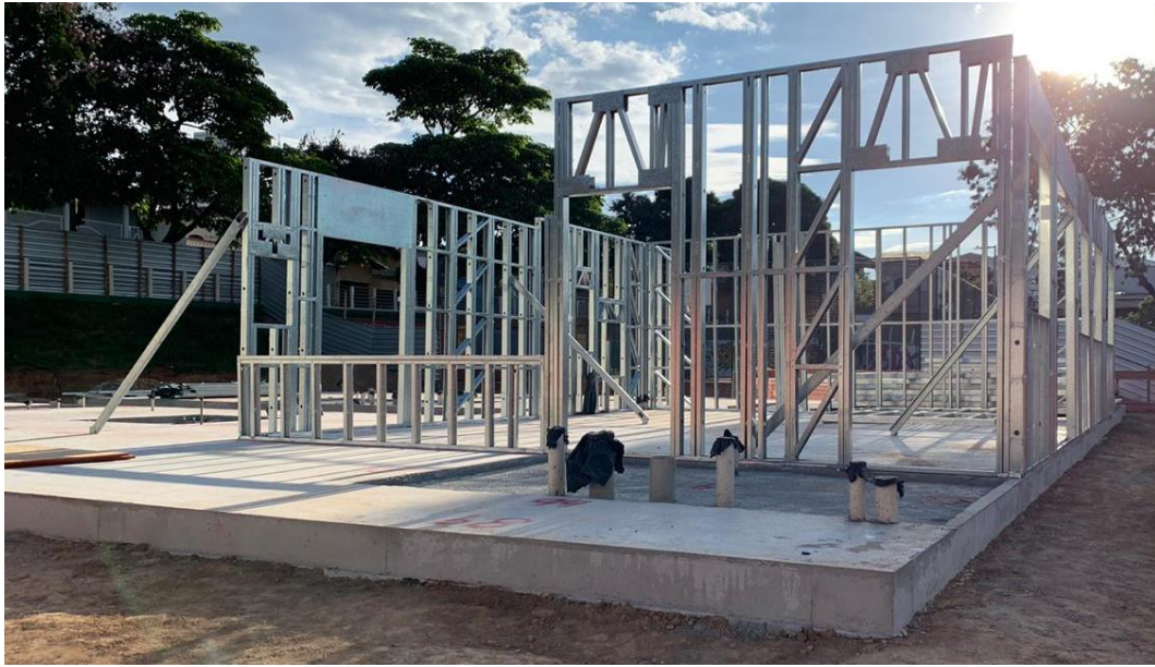
Figura 2 - Fixação de painéis LSF, Centro de Saúde Túnel de Ibirité
