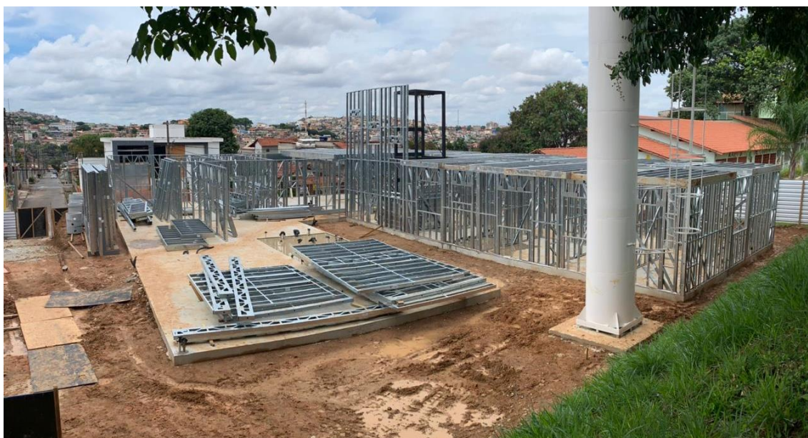
Figura 3 - Construção de Centros de Saúde em LSF
