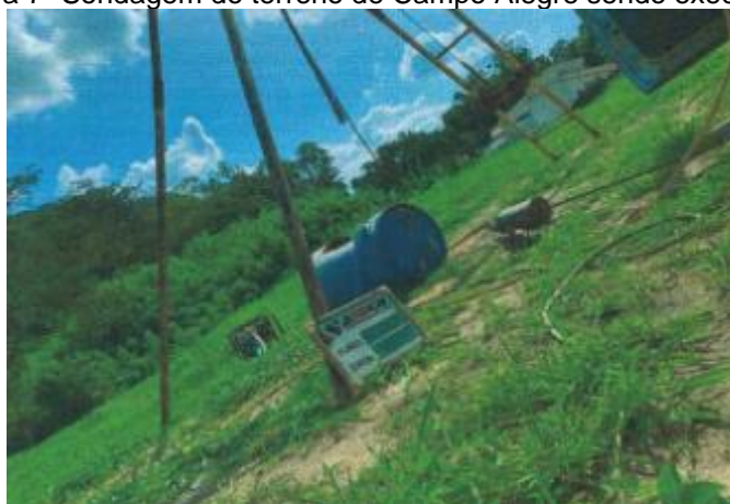
Figura 7- Sondagem do terreno de Campo Alegre sendo executada
