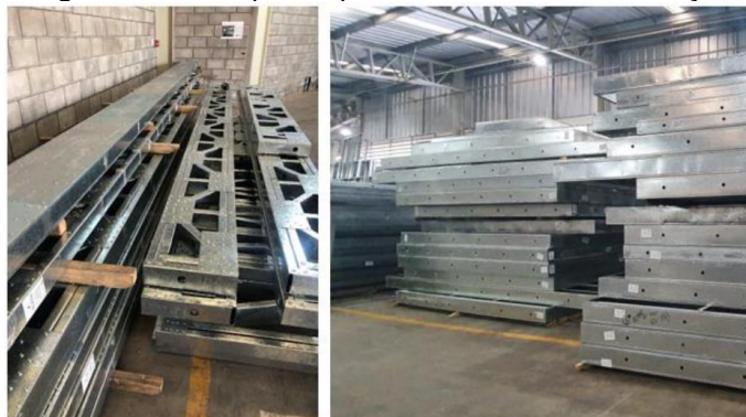
Figura 31 - Estoque de painéis de cobertura e treliças
